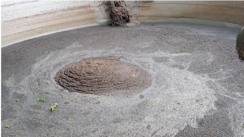
**Bild B.15 Schwimmschicht im Gülletank, bestehend primär aus Fasern und Fliegenpuppen**
