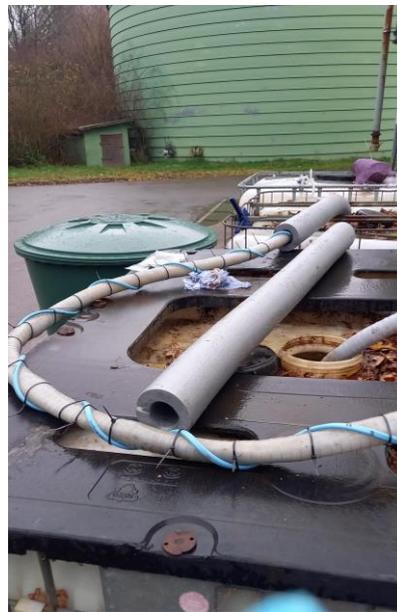
**Bild B.17 Rohrbegleitheizung und Dämmung der Zulaufleitung**
